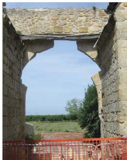
**Samedi 13 septembre 2003, un chariot élévateur sortant du village heurtait le haut de la porte médiévale et faisait chuter les pierres de l'arc ogival. Le reste de la voûte ébranlé devra être démonté. Les dégâts sont considérables, estimés à plus de 20 000 euros. Les réparations doivent être effectuées avant que nous puissions débiter notre projet de restauration de la porte. Le passage a été fermé et le village offre un bien triste spectacle. ■**
